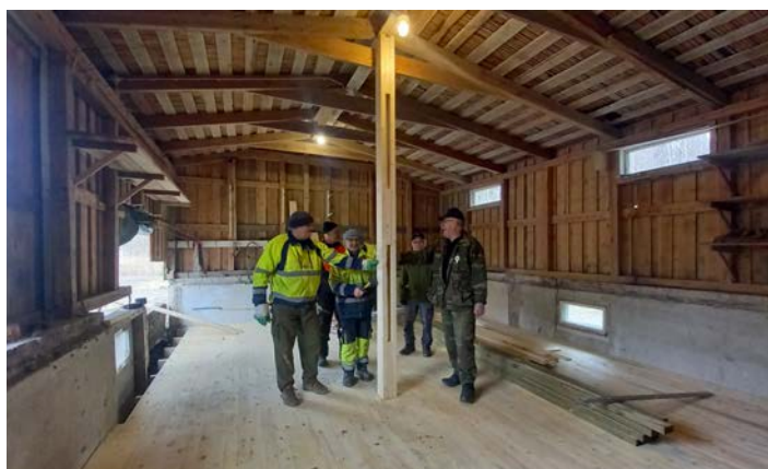
Varastotilan lattia valmiiksi
