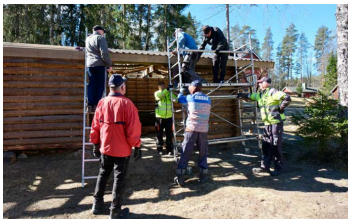
Hirsikatosten katon tekoa
