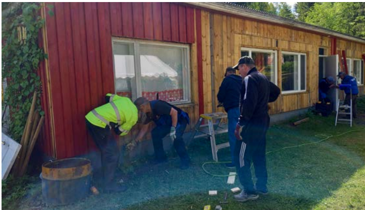
Etuseinän uusimista, maalausta, oven vaihto
